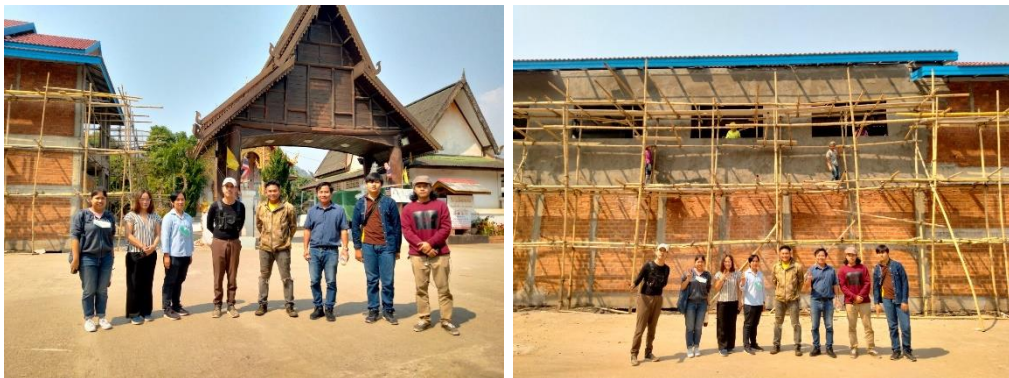
ภาพที่ 25 สำรวจสถานที่ก่อสร้างสำหรับเตรียมแผนการวาดภาพฝาผนัง
